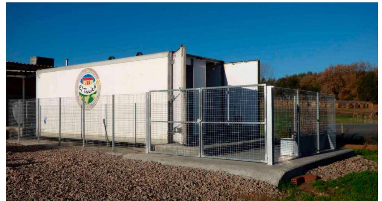
Matadero en la explotación instalado en una caja de un camión adaptada, en el Soler de n'Hug (Girona) ©Abel Peraire.
